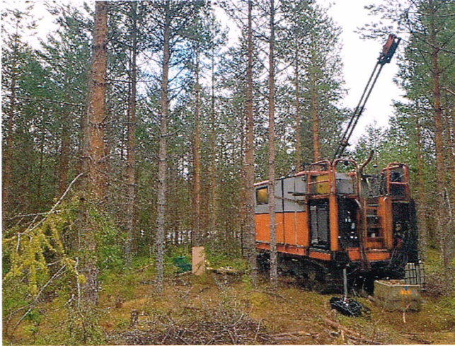
Figur 3. Exempelbild på kärnborrhög i arbete.
